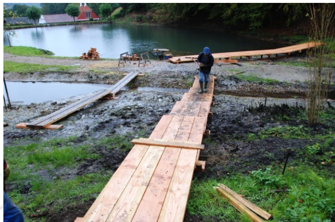
Okt. 2014 Gangbroer og trapper etableres
