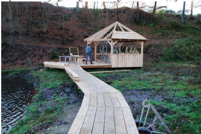
Nov. 2014 Der arbejdes på madpakkehuset
